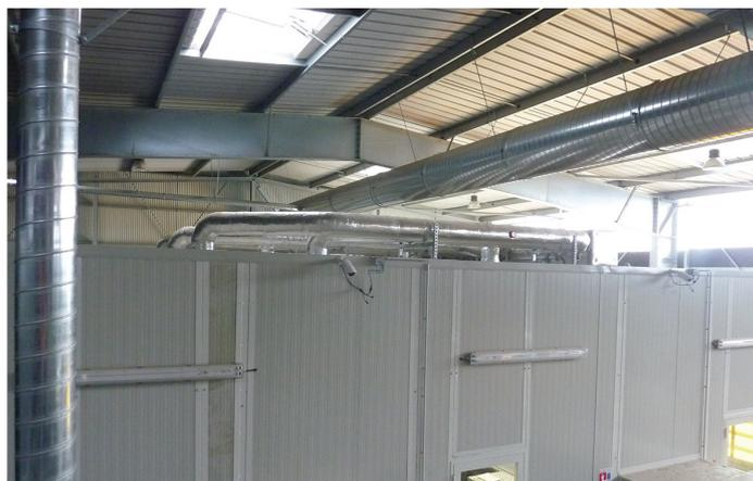
Vue en hauteur d'une cabine de tri avec plénum soufflant/tunnel acoustique/lumière extérieure
