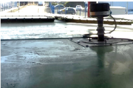
Figure 12: benne avec évents de décharge d'explosion et sonde de niveau
