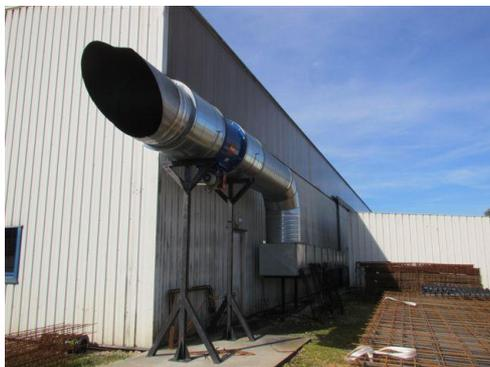
La ventilation générale permet de diluer les polluants non captés à la source. Elle ne peut être utilisée comme principale technique d'assainissement de l'air que lorsque le captage localisé est techniquement impossible.
