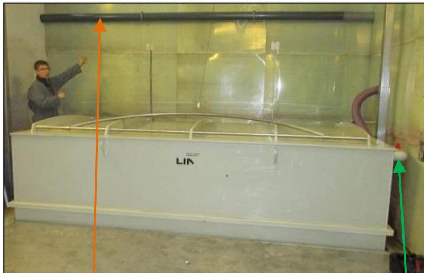
Conduit de rejet à l'extérieur et cuve avec bouche d'extraction
