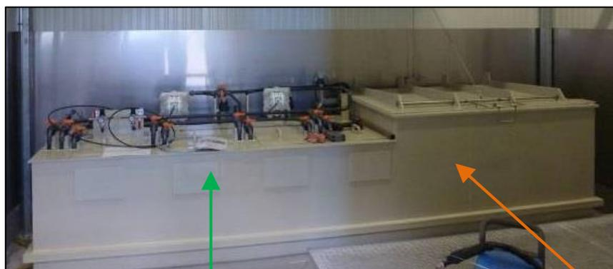
Cuves de stockage (à gauche) et cuve de traitement (à droite)
