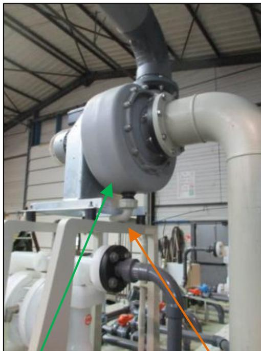
Ventilateur d'extraction avec récupération des condensats
