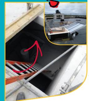
Risque de chute depuis l'échelle par-dessus les garde-corps bordant la cage d'escalier.
