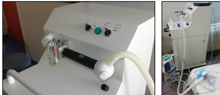
Photos 8 et 9 : Centrale à haute dépression (0,25 kW)
