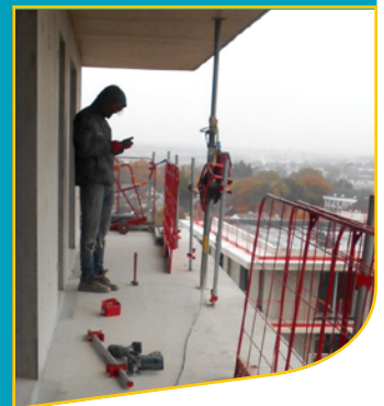
Retrait des protections de chantier avant la pose des garde-corps définitifs.
