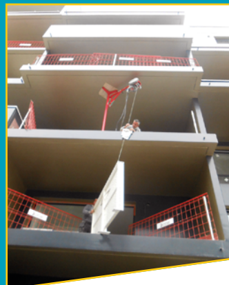
Retrait des protections de chantier avant la pose des garde-corps définitifs.
