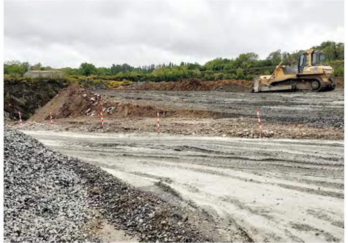
Principe de drainage de l'eau en double pente
