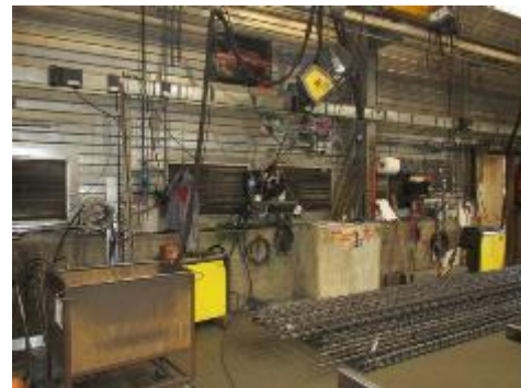
Soufflage tout air neuf et extraction mécanique sur parois opposées
